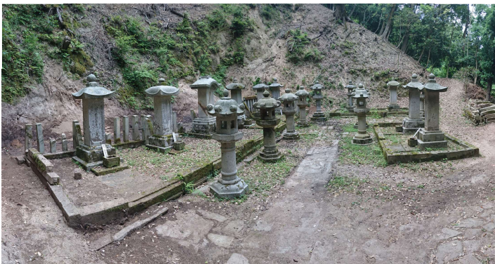
墓石は復旧し周囲の土砂を撤去 令和2年6月
